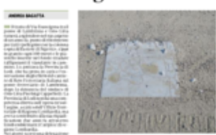
Il cantiere di Castelnuovo per la ricostruzione della strada della Francigena.
