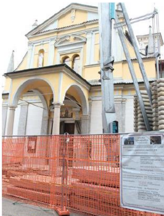
IL CANTIERE I lavori erano già preventivati, poi è arrivato il terremoto
