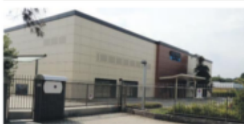
IL PROGETTO: IL PIANO PROPONE DI ADEGUARE UN CANTIERE IN VIALE MILANO
