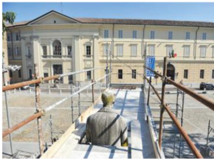
IL RESTAURO Una suggestiva immagine del cantiere di piazza Ospitale
