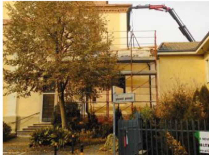
IL CANTIERE Ponteggi e gru attorno alla chiesa di Sant'Andrea apostolo
