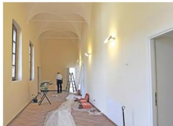
ULTIMI LAVORI La ristrutturazione si sta concludendo in questi giorni
