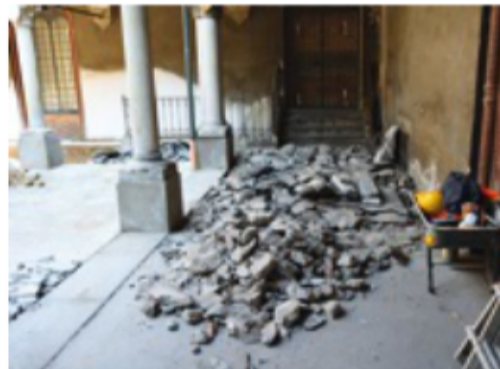
SCAVI Qui sopra le pietre, sopra le demolizioni
