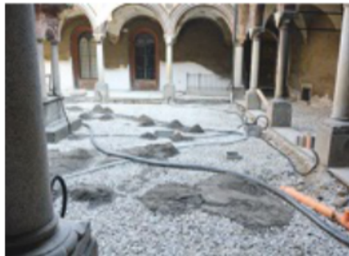
ACCIOTTOLATO La posa di sassi di fiume e sabbia
