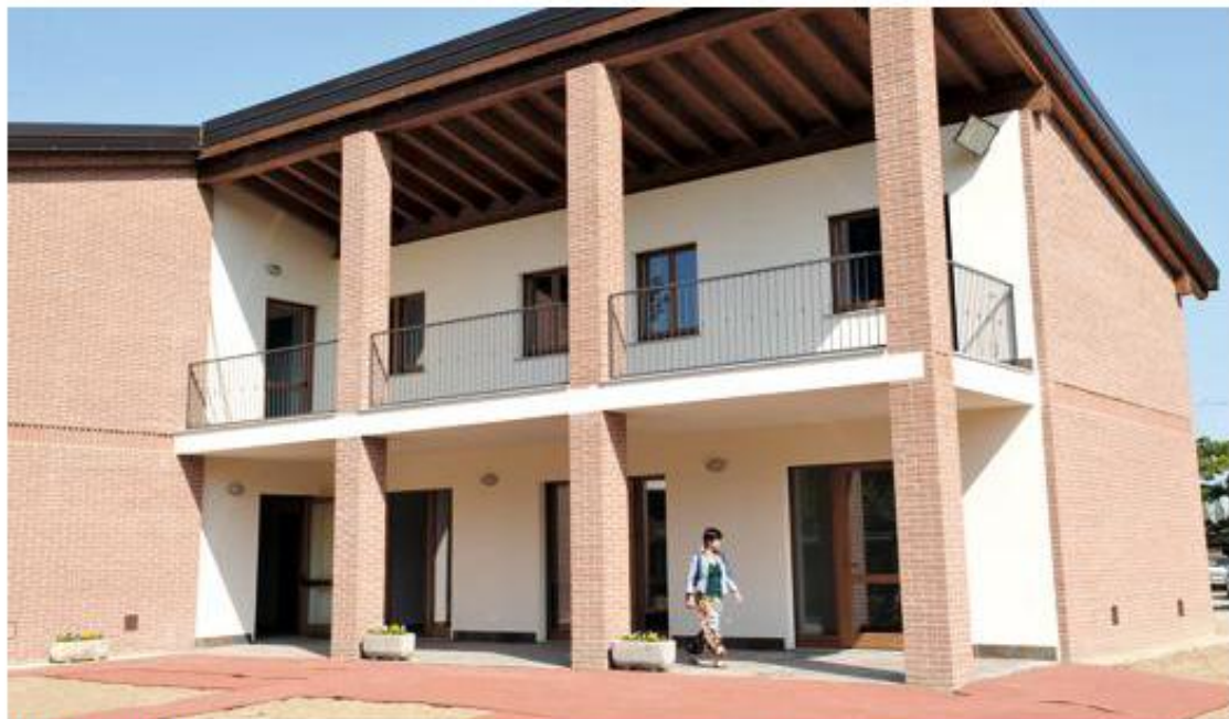
HOUSING SOCIALE Una parte della struttura di accoglienza nella comunità che al momento ospita ventisette persone
