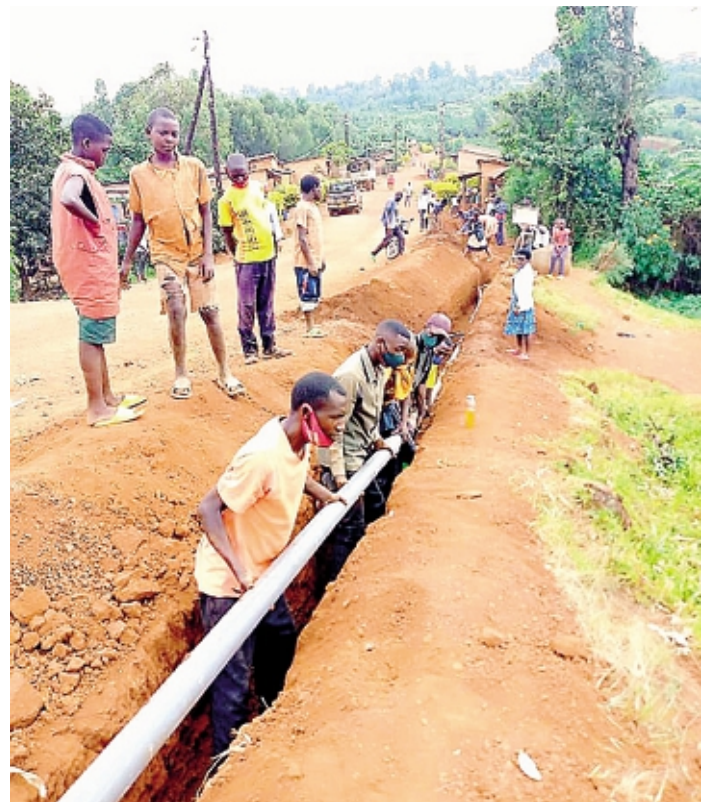
I lavori per gli acquedotti in Ruanda, nella foto piccola Antonio Colombi
